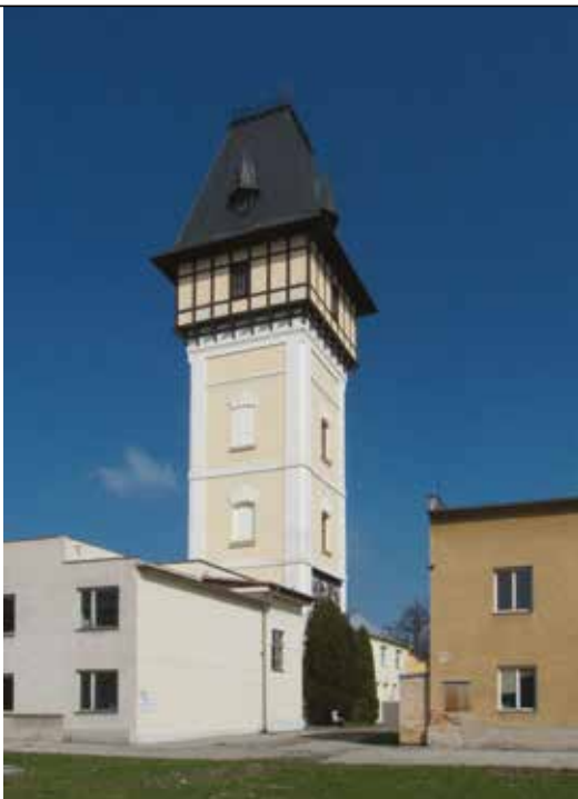
Vodárenská věž České Budějovice
